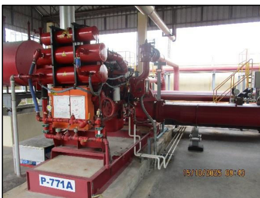
ภาพถ่ายที่ 2.2-26 เครื่องสูบน้ำดับเพลิง
