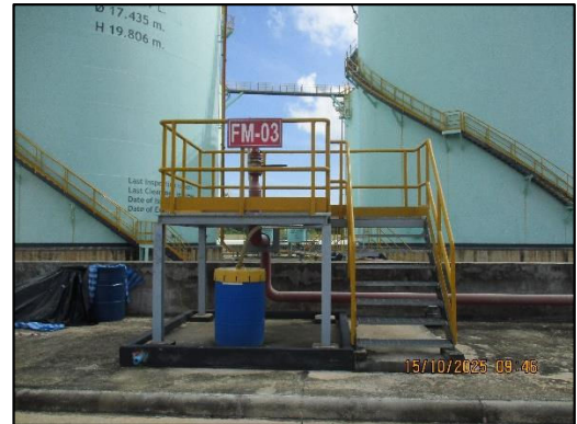
ภาพถ่ายที่ 2.2-27 ระบบฉีดน้ำดับเพลิงแบบโฟมและระบบผสมโฟมสำหรับดับเพลิง
