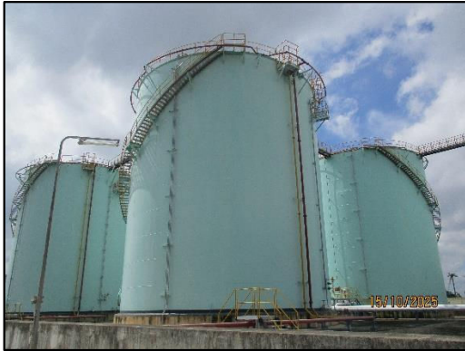
ภาพถ่ายที่ 2.2-24 ระบบฉีดน้ำดับเพลิงและระบบสเปรย์น้ำหล่อเย็น บริเวณถังเก็บน้ำมัน
