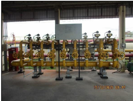
ภาพถ่ายที่ 2.2-27 ระบบฉีดน้ำดับเพลิงแบบโฟมและระบบผสมโฟมสำหรับดับเพลิง
