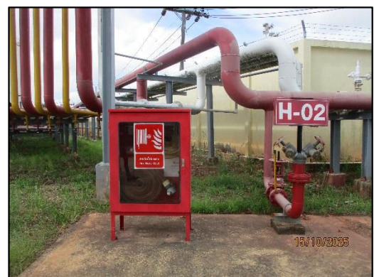
ภาพถ่ายที่ 2.2-23 ระบบท่อน้ำดับเพลิง และสายฉีดน้ำดับเพลิง
