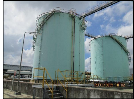
ภาพถ่ายที่ 2.2-24 ระบบฉีดน้ำดับเพลิงและระบบสเปรย์น้ำหล่อเย็น บริเวณถังเก็บน้ำมัน
